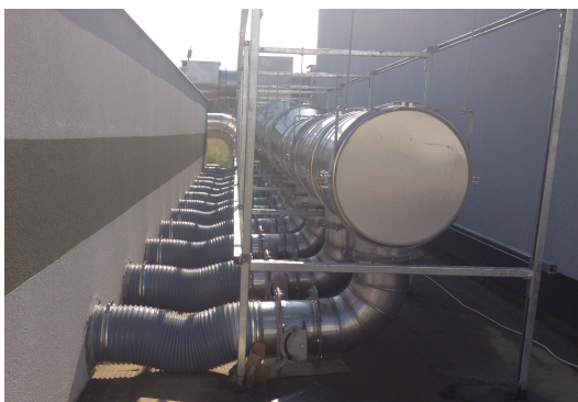
(4) SISTEMA DI AERAZIONE FORZATA
